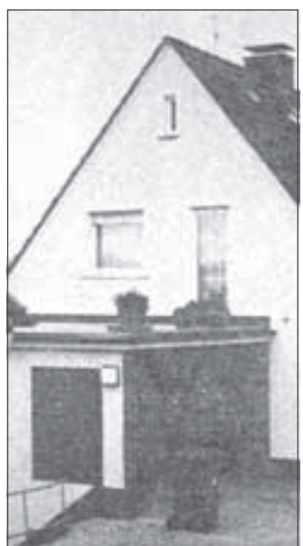
Eines der ersten Häuser: An der Sundheller Straße, errichtet von 1937 bis 1938.
